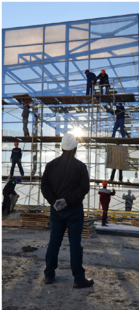
На фото монтаж светопрозрачных конструкций олимпийского павильона компании «Роснефть» в Сочи.
